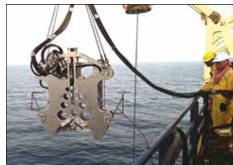
▲ Piła linowa diamentowa MDWS opuszczana do morza
