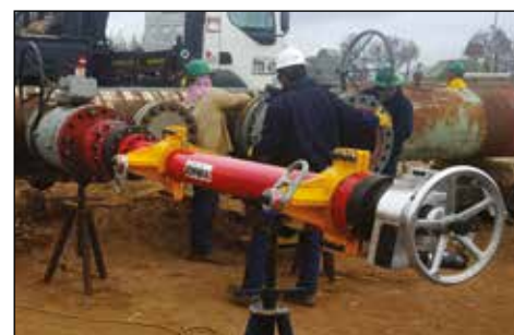
▲ Model CHT3000 wykorzystywany do prac hermetycznych przy instalacji rurociągu petrochemicznego
