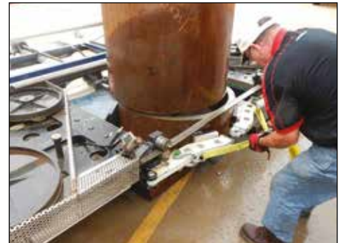
▲ Przecinanie rury za pomocą przenośnej piły taśmowej BS.
