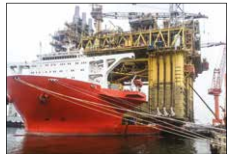
Synchroniczne podnoszenie i przesuwanie
