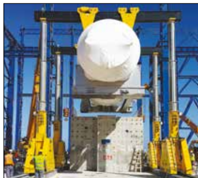
▼ Suwnica SBL1100 podczas przeladunku dużego generatora do zainstalowania w elektrowni
